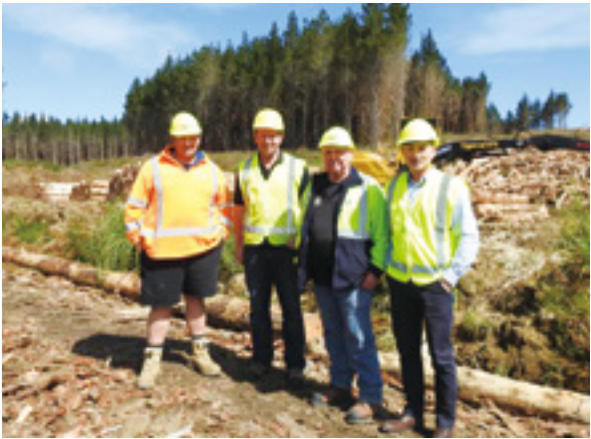
修建基础设施现场
